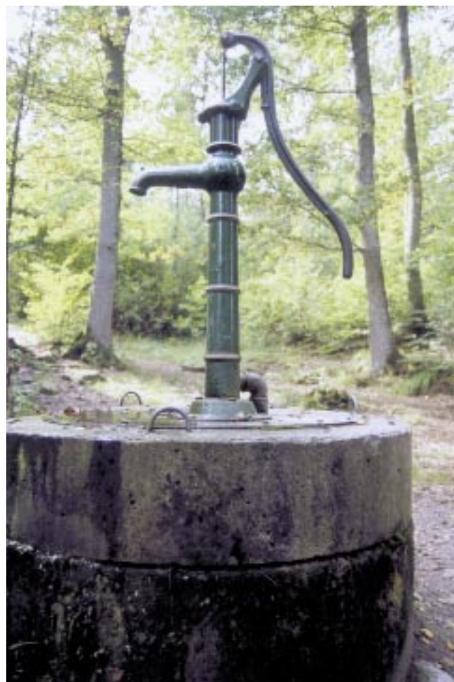
Grävd brunn i jordlager
